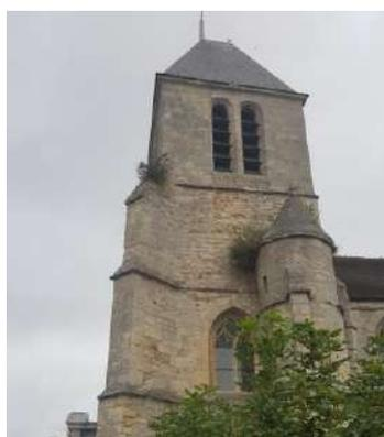
*Maçonneries du clocher, en pierres de taille et moellons enduits*
