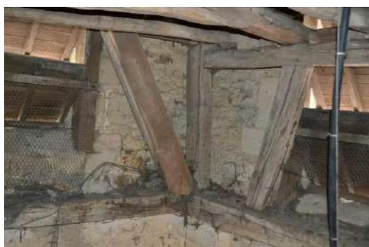
*Charpente inférieure du beffroi reposant sur les corbeaux.*
