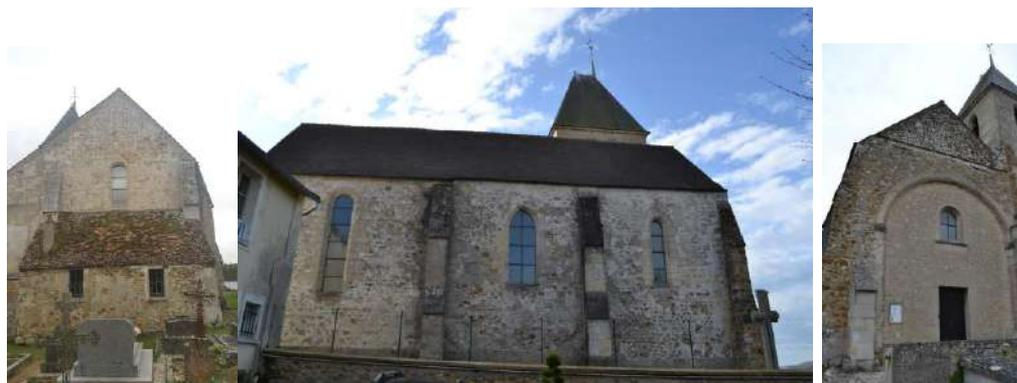
*Maçonneries de la nef et du chœur en moellons enduits*
